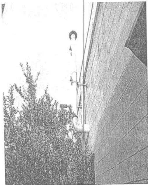
Foto 7. Chimenea proveniente del proceso de cementado.
